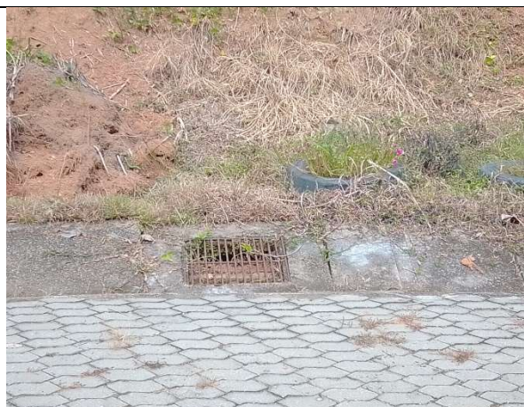
Imagem 14 – Detalhe da calha/canaleta de drenagem
