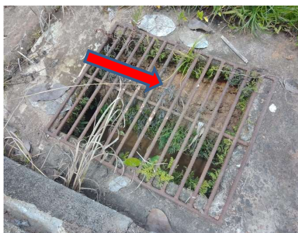
Imagem 16 – Detalhe da grelha com parte do solo que entrou na caixa de inspeção
