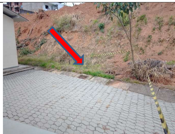
Imagem 13 – Vista da calha/canaleta de drenagem que “estufou/inflou” em função do escorregamento rotacional do talude
