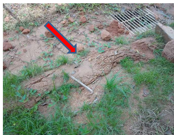
Imagem 15 – Detalhe da região da base do talude estufou em função do escorregamento ocorrido
